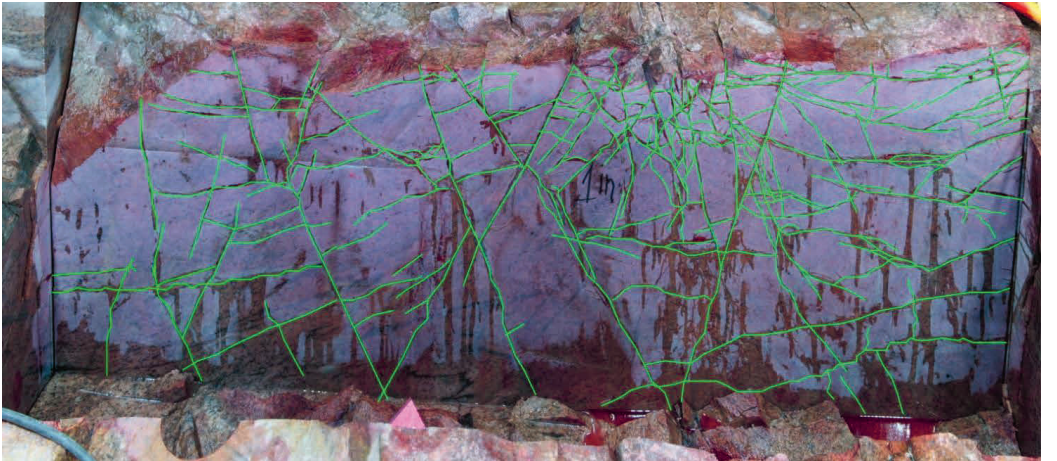
Figur 26. Snittytan TAS04, Sula sektion 25,5 in med penetranter samt med inlagda spricktyper.
