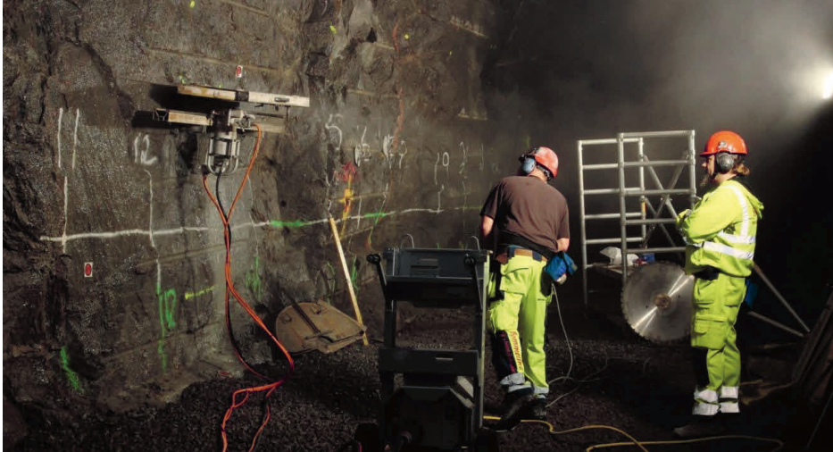
Figur 10. Sågning av slits i väggen, TASN sektion 13 m.
