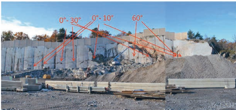
Figur 8 Lerfyllt sprickslag längs en stor del av bergslänten
